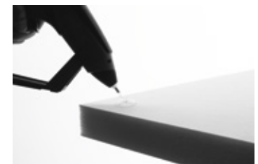
Wand- und Deckenmontage
